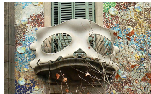
Fotografía. Vista de las barandas.
