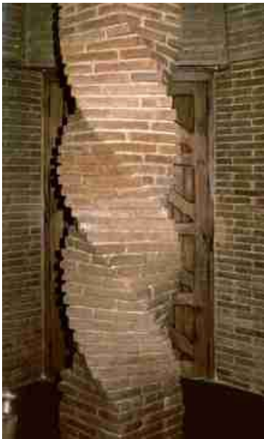
Fotografía. Columna de ladrillo
