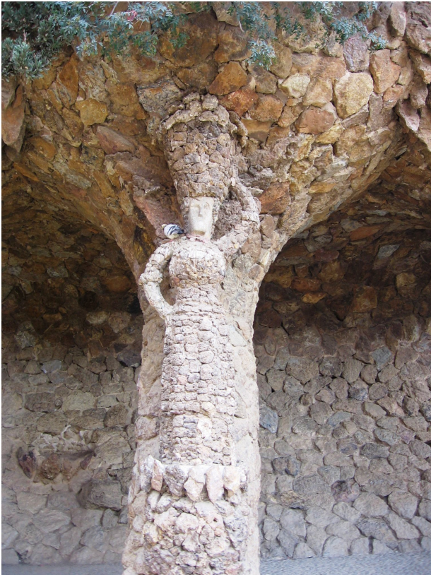
Fotografía. Detalle de una de las columnas.
