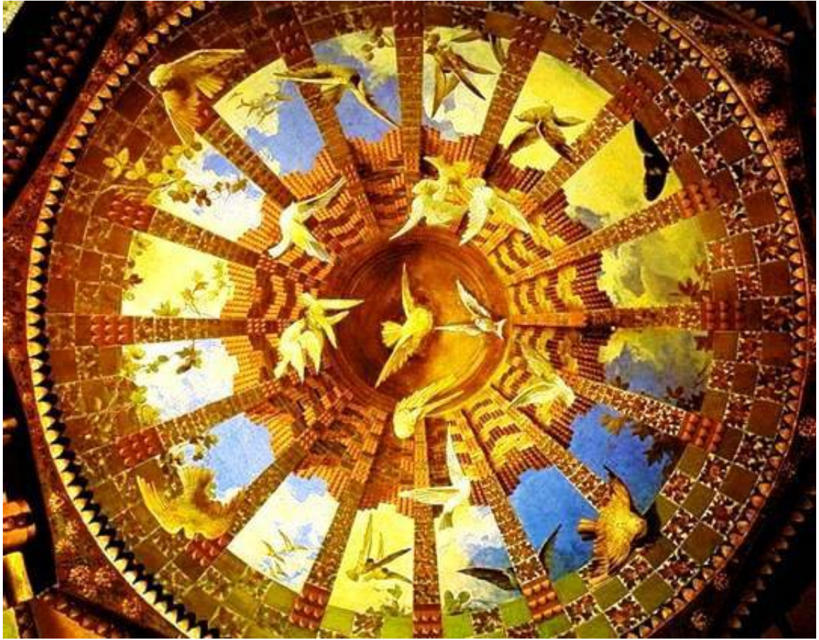
Fotografía. Vista general de la cúpula
