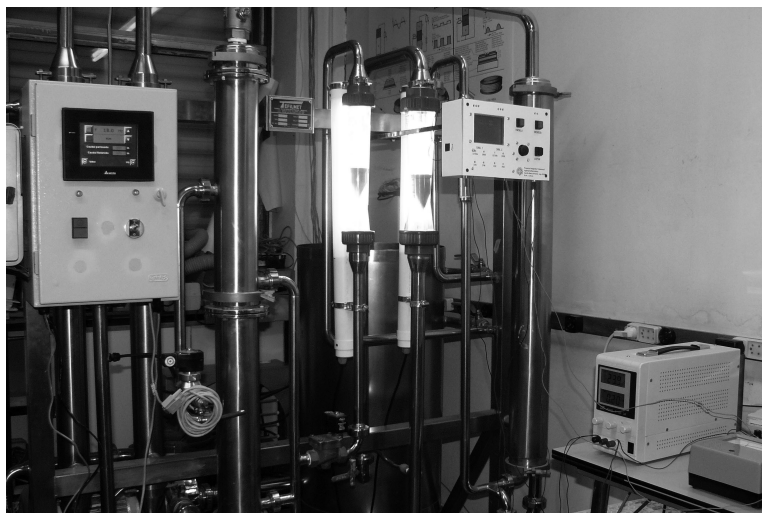
Fig. 1 . Planta piloto con el transductor montado
