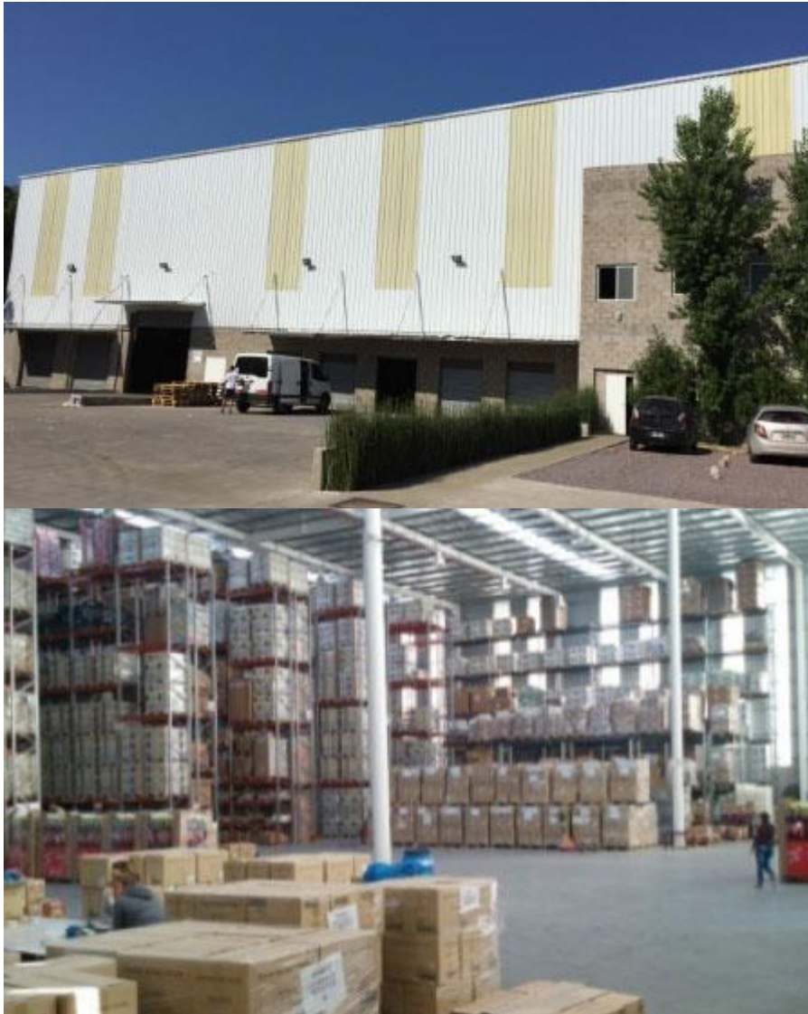
Imagen 2 Área de maniobras. Área de staging y estanterías en espacio aéreo de 10 metros de altura.
