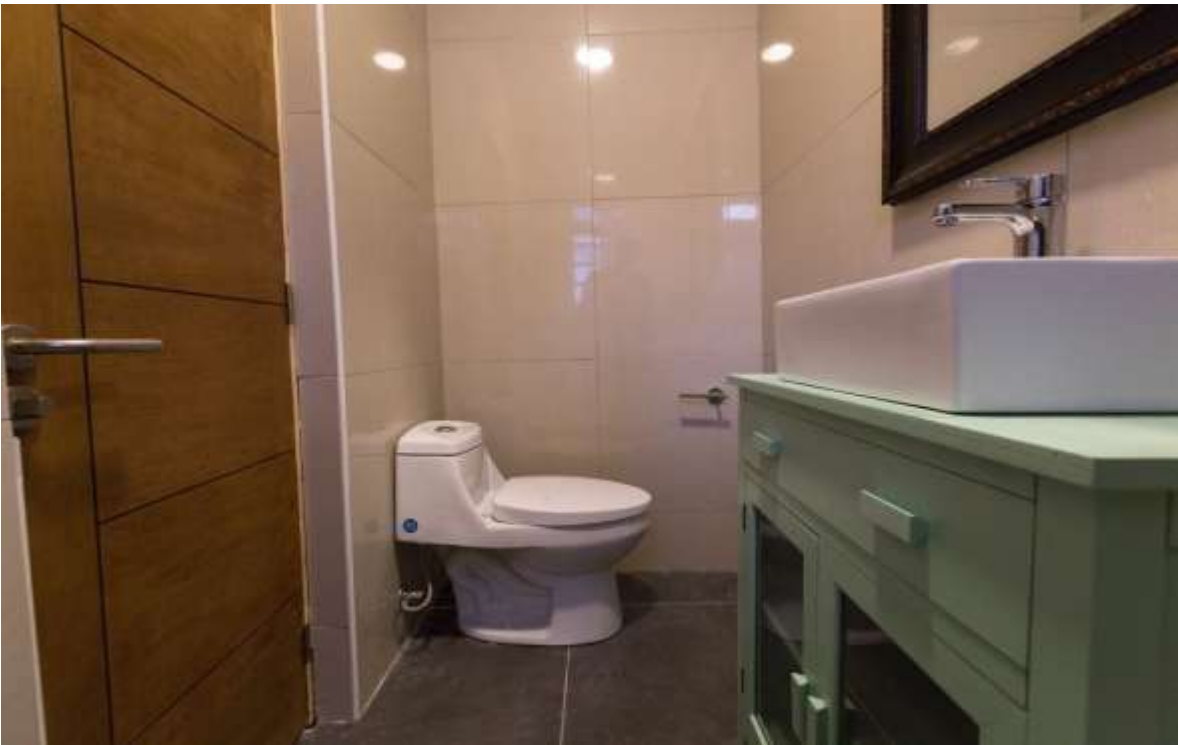
Figura N°17: 05 Baños habilitados en segundo piso. –Equipamiento sanitario.-
