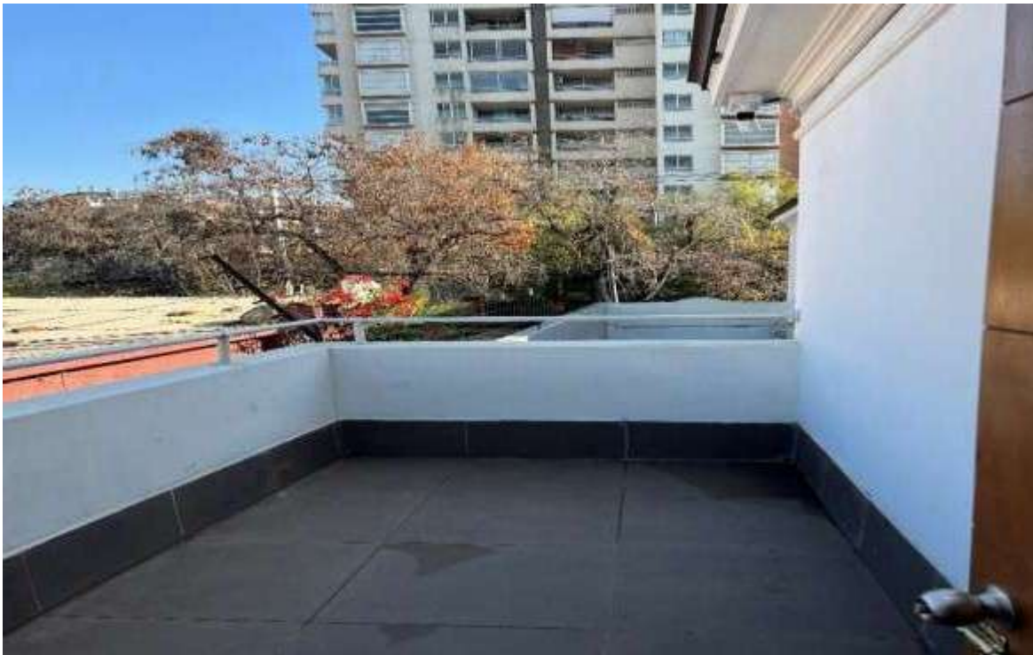
Figura N°19: Terrazas exteriores en segundo piso. -Espacios abiertos- Fotografía: Cristian Prado Valenzuela.
