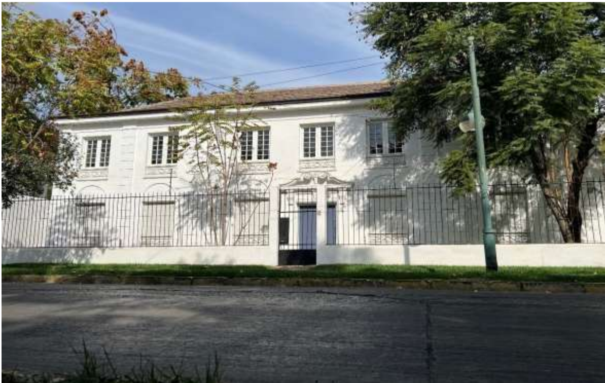
Figura N°21: Estacionamientos públicos frente a “Casona Infante” sobre calle Rengo – Uso habitual efectuado por los ocupantes y reconocimiento comunitario.- Fotografía: Cristian Prado Valenzuela.
