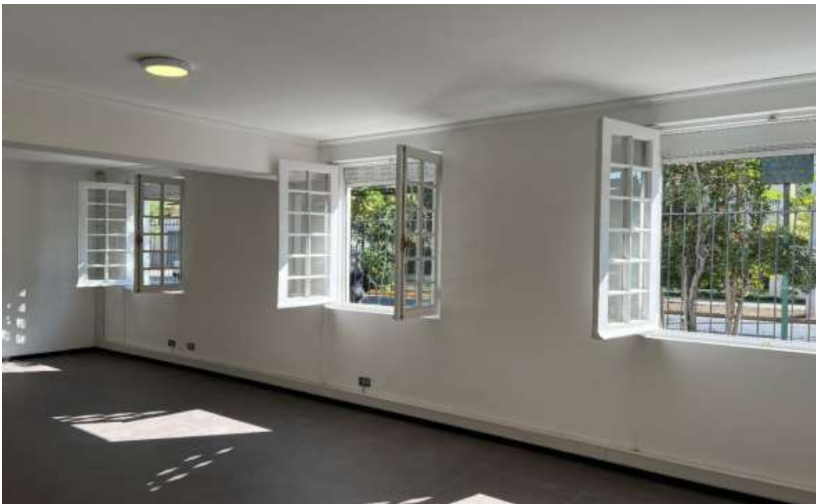
Figura N°11: Ventanas en múltiples orientaciones. -Aporte de luminosidad natural y ventilación cruzada.- Fotografía: Cristian Prado Valenzuela.
