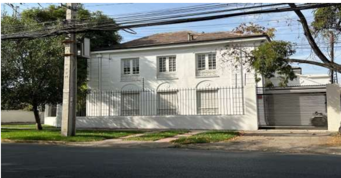
Figura N°2: Vista lateral de “Casona Infante” desde calle José Manuel Infante - Fachada secundaria y entorno inmediato.- Fotografía: Cristian Prado Valenzuela.
