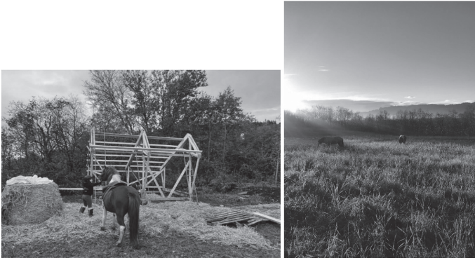
Figura 9. Refugio para caballos en construcción, siendo probado y revisado por uno de los clientes.
