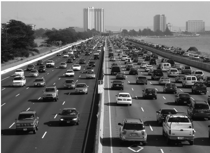
Figura 3. Autopista I-80_Eastshore en Berkeley, California, 2005.
