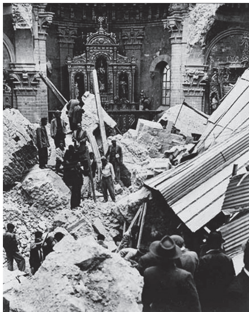
Figura 11. Ambato. Iglesia Matriz. Restos de las bóvedas colapsadas por el terremoto de 1949 (Archivo Blomberg).
