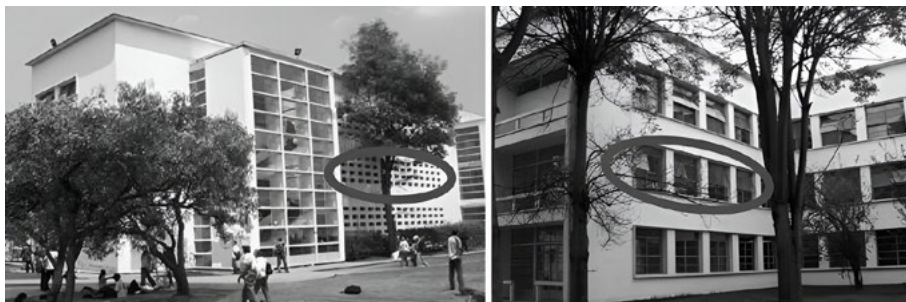
Fig. 18 Escaleras de proyectos de Leopoldo Rother. Fuente: Elaboración propia
