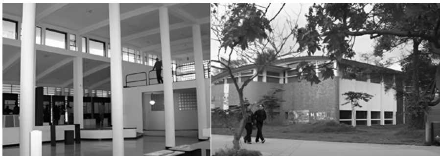
Figura 15. Cubierta curva del edificio de la imprenta de la Universidad Nacional. Fuente: Elaboración propia
