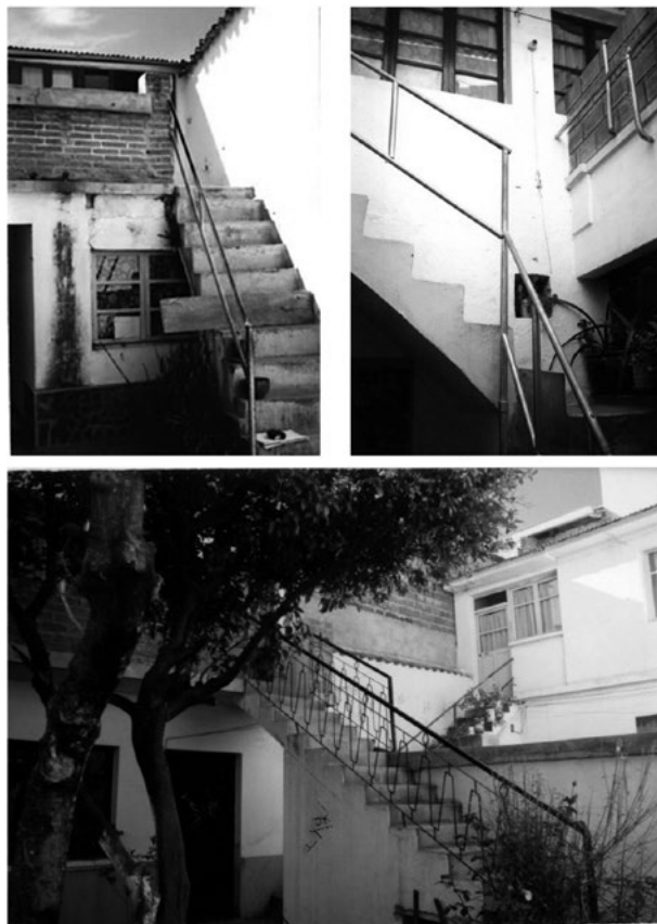
Figura 8. Escaleras exteriores en L y rectas. Obtenidas de Fichas Patrimonio Histórico
