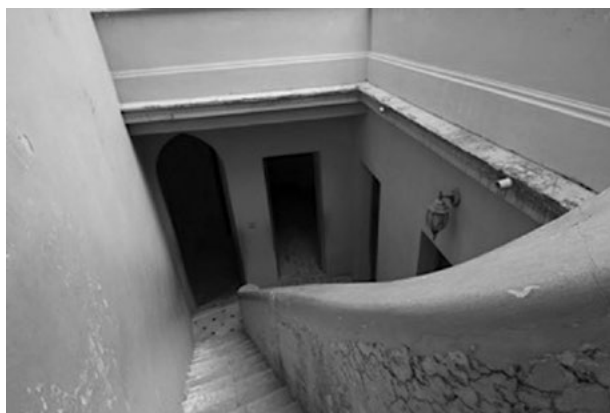
Figura 3. Escalera y patio de servicio en el Castillo de la Glorieta. Fotografía propia
