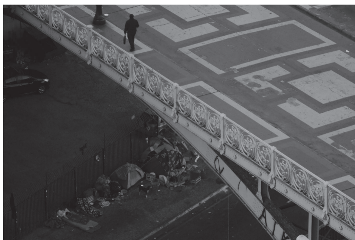
Imagem 4. O viaduto como telhado da moradia. Fonte: Produzido pelo autor, 2023.
