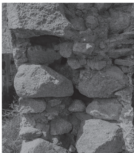
Ilustración 1. Muros de mampostería, a base de piedra de río y asentada con mortero de barro, fuente propia, 2024.
