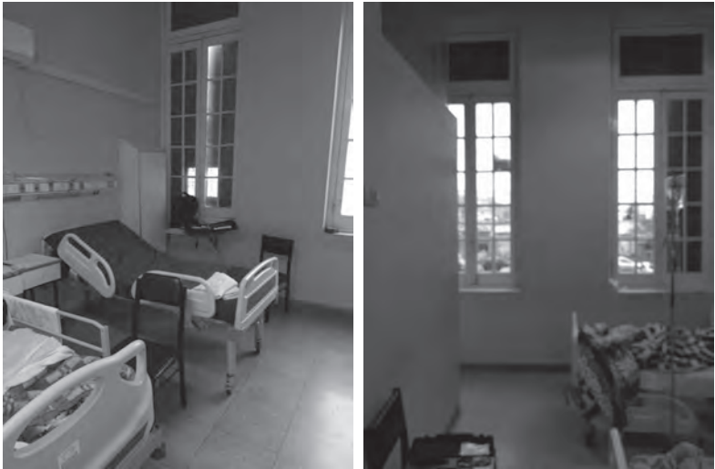
Figura 4. Izquierda: ubicación de AD en pabellón Rossi. Derecha superior: interior sala 5 (sureste). Derecha inferior: interior sala 12 (noroeste). Fuente: elaboración propia
