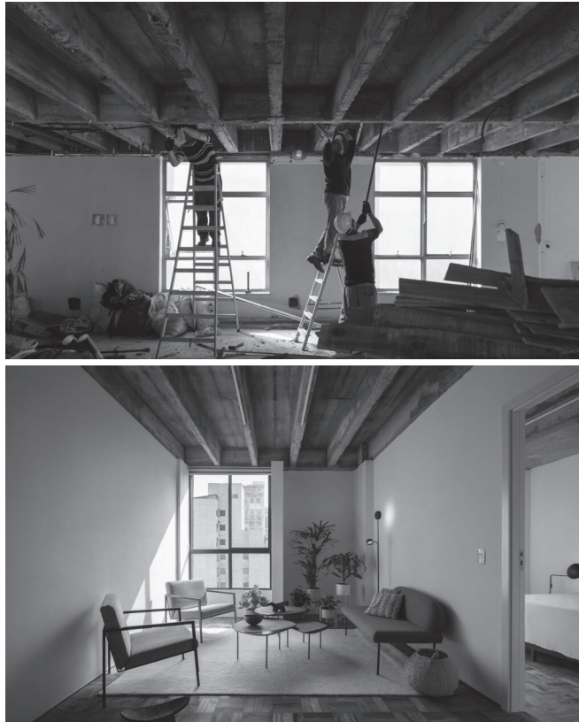
Imagen 6. Interior viviendas Edificio Joao de Barro
