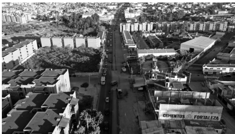
Foto 4. Desde esta perspectiva se puede apreciar la invasión al espacio público del conjunto habitacional San Patricio y la invasión del espacio público de quienes colindan con la avenida. Fuente: Castillo, 2026
