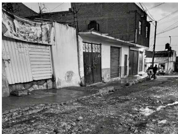
Figura 2. Entorno deteriorado en la zona de Ciudad Cuauhtémoc Fuente: Fotografía Archivo Personal Valiñas 2025
