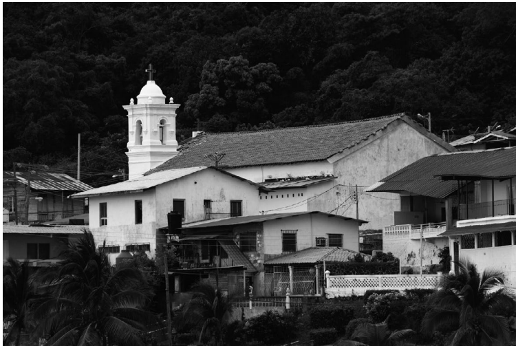
Figura 6. Iglesia de San Pedro de Taboga se destaca aun en medio de la naturaleza y construcciones aledañas. Taboga, Panamá. Fuente: Elaboración propia.
