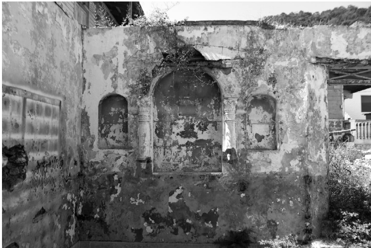
Figura 5. Vestigios de viejas estructuras, construcciones y altares. Isla Taboga, Panamá. Fuente: Elaboración propia.
