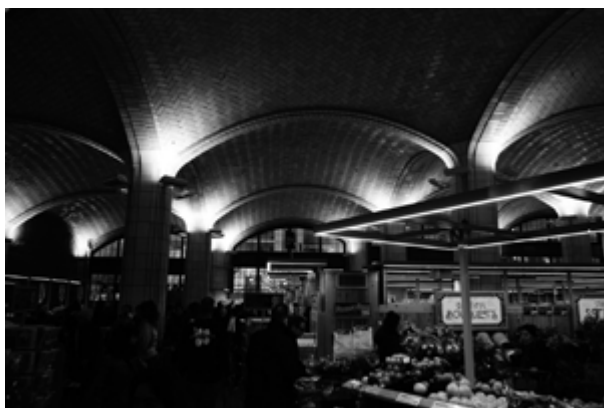
Figura 15. El tradicional Bridgemarket , bajo el Queensboro Bridge en Manhattan, hoy restaurado, modernizado y abierto al público. Trader Joe's, Bridgemarket, Queensboro Bridge , Nueva York, EEUU. Fuente: Elaboración propia.
