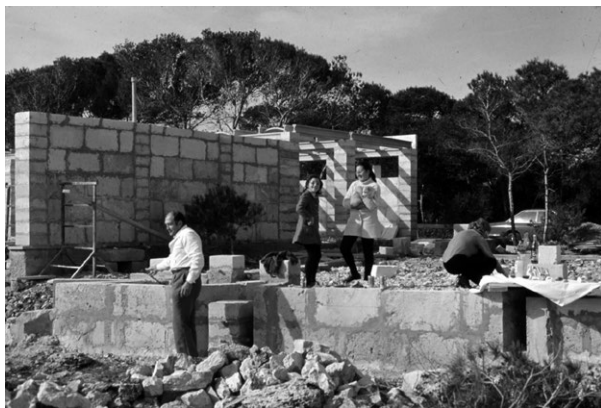
Figura 10. Picnic en el borde del muro durante la construcción. Una apropiación intensa del lugar y del paisaje. © Utzon Archives / Aalborg University & Utzon Center
