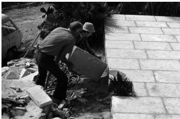
Figura 5. Decisiones afinadas. Recorte del pavimento para dar lugar a la vegetación. © Utzon Archives / Aalborg University & Utzon Center
