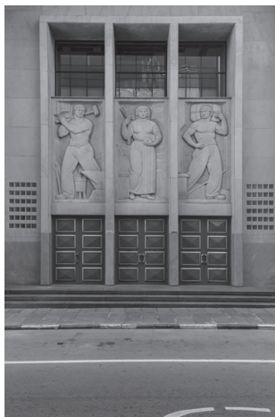
Imagen 10. Banco La Caja Obrera. Fachada 25 de Mayo. Reforma 1947. De Los Campos, Puente y Tournier. Marcos Mendizábal. BMR Productora Cultural.
