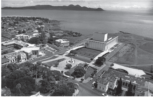
Figura 11. Teatro Nacional Rubén Darío (c. 1970). Se observa la relación entre volumen principal y columnata perimetral, así como el contraste entre abstracción moderna y pre-existencias urbanas (antiguo Club Social Managua). Fuente: Historia de Managua.
