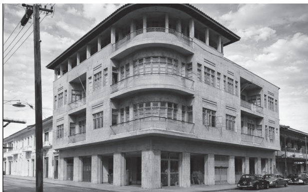
Figura 4. Edificio Pereira (c. 1945), obra del Ing. Pablo Dambach. Ejemplo temprano de edificio de uso mixto en Managua, con comercio en planta baja, oficinas y vivienda en niveles superiores. La imagen destaca su volumetría limpia, balcones curvos y soluciones de adaptación climática. Fuente: Archivo Jeanine Pereira Bernheim (2026).
