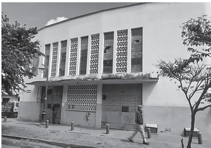
Figura 1. Estado de abandono del teatro Juan Benigno Vela.
