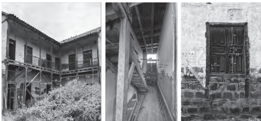
Figura 2. (Izq.) Patio interior. (Dcha.) Escalera y pasillo de ingreso.
