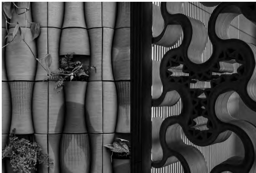
Imagen 4. Jardín vertical de barro cocido y celosías realizadas por extrusión con impresoras 3D. Foto: Pedro Guerrero Serrano
