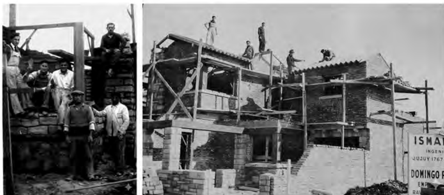
Figura 2. Construcción de chalets en Mar del Plata: Mario Castañón, picapedrero, junto a un grupo de obreros; Carpintería y Aserradero Mariano Orensanz e Hijos en obra, año 1939. Fuentes: Archivo particular, familia Castañón Venturi, gentileza del profesor Francisco Ramallo y blog Fotos viejas de Mar del Plata: https://fotosviejasdemardelplata.blogspot.com/2018/09/carpinteria-de-mariano-orensanz-e-hijos.html
