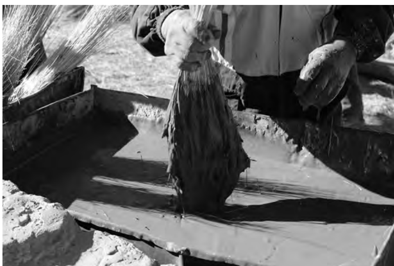
Figuras 1 y 2. El hacer en las culturas constructivas con tierra, a través del alisado de una torta de barro y la preparación de la paja para un techo (Fotografías de los autores)
