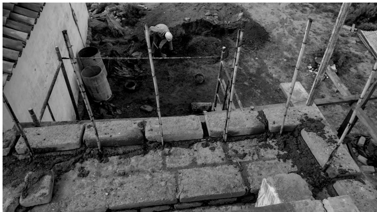
Figura 6. Incorporación de cañas verticales en la mampostería de adobes (fotografía de la autora)
