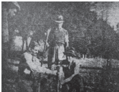
Figura 1. Puesta de la primera estaca en la construcción del pabellón de Bata Chile en Peñaflor c.1939 (Fuente propia).
