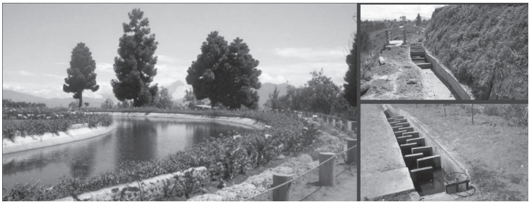
Figura 4. Canal de riego con escalinata y disipadores. Nota. Tramo bajo del canal de riego, se encuentra integrado a la red de circulación interna del parque, favoreciendo al drenaje pluvial en zonas recreativas. Elaboración propia 2025.
