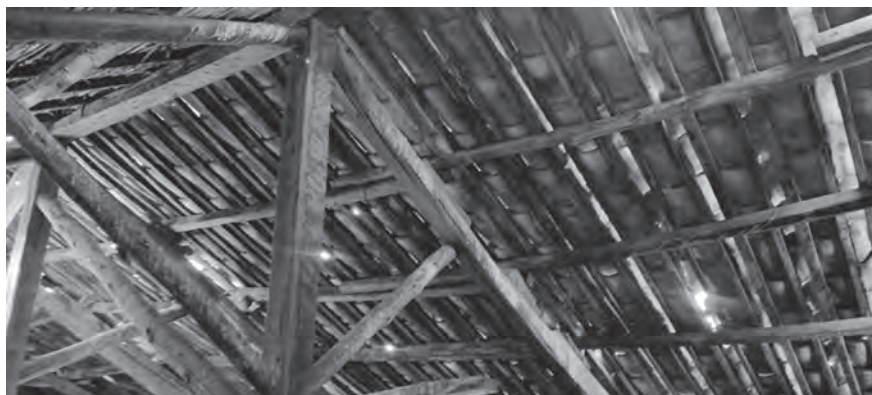
Figura 3. Cubierta con cerchas de madera y teja.
