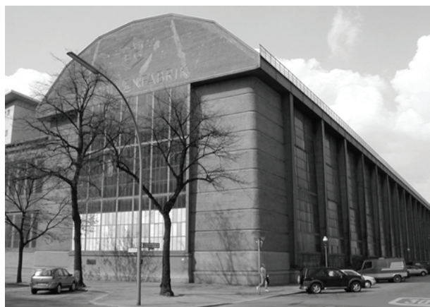
Imagen 1. Fábrica de turbinas de la AEG, 1908. Peter Behrens. Fuente: https://europeancollections.wordpress.com/2018/08/17/peter-behrens-150/aeg/
