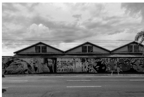
Figura 3. ¡Imagine la vista! Imagen parcial de un tramo del Muro de la Av. Mauá. (2015). Foto: Felipe Conde.
