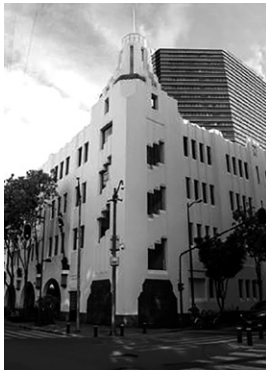
Imagen 2. Tipo de edificación perteneciente al Art Deco perteneciente al género de los edificios públicos. La Estación de Policía y bomberos, por el Arq. Vicente Mendiola (1928). Foto de la autora.
