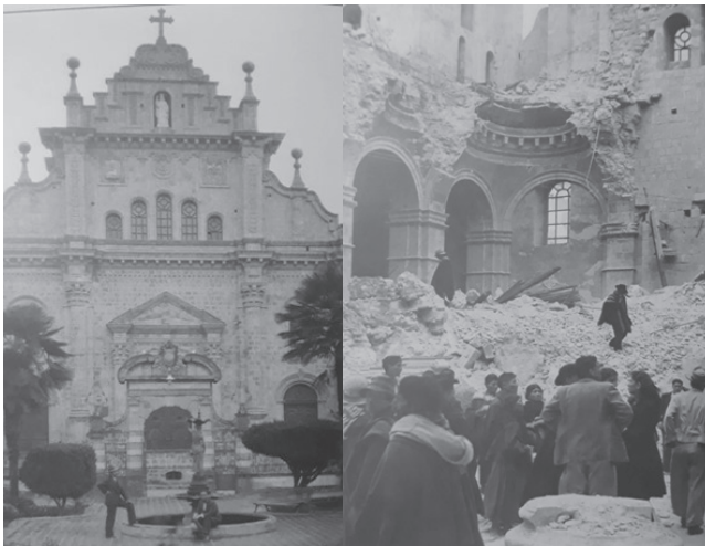
Figura 1. Fachada de la Iglesia Matriz (1930) - La iglesia en ruinas (1949). Fuente: Imágenes Ambato. Fotografías de José Paredes. 2010.
