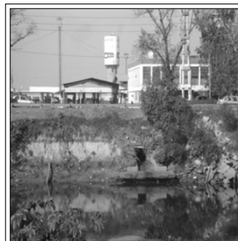
Imagen 5. Desagüe fabril, altura del Puente La Noria.
